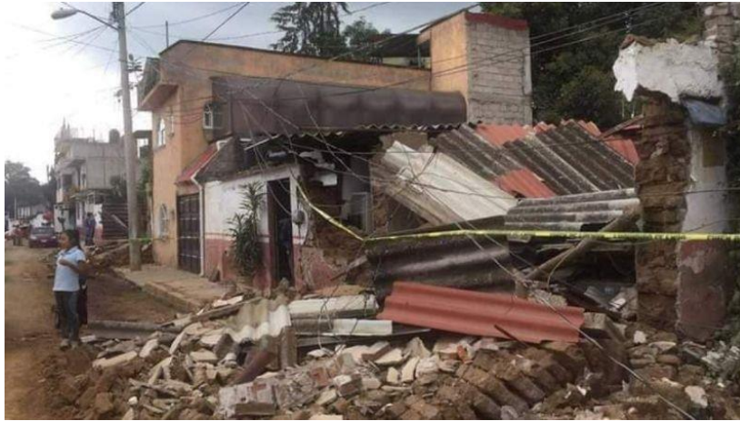
Daños por el sismo en Michoacán. Foto: Especial
