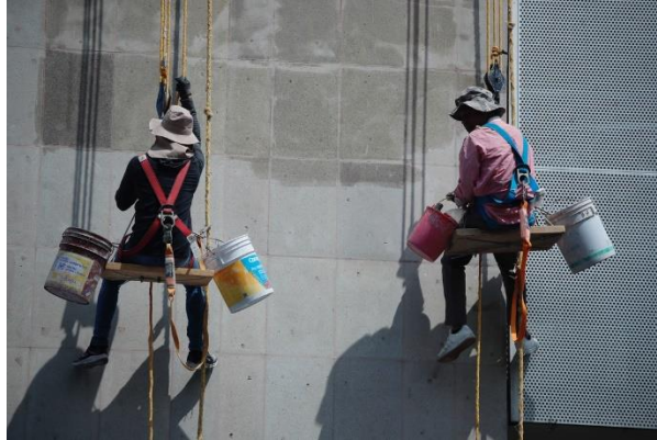
Trabajadores limpian una pared de un edificio en el Centro Histórico capitalino. Foto Cristina Rodríguez / Archivo
